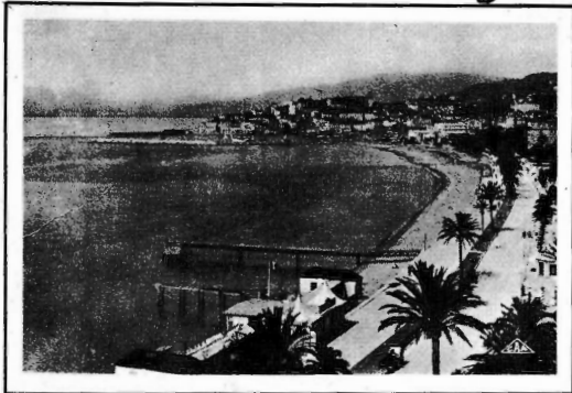
Cannes: vista general.
